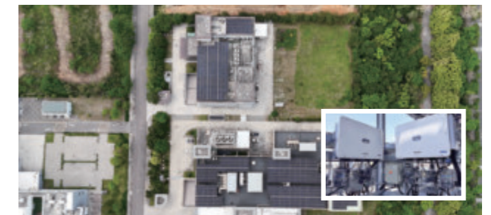
| 台湾友森生技制药厂光伏项目 499.96kW
